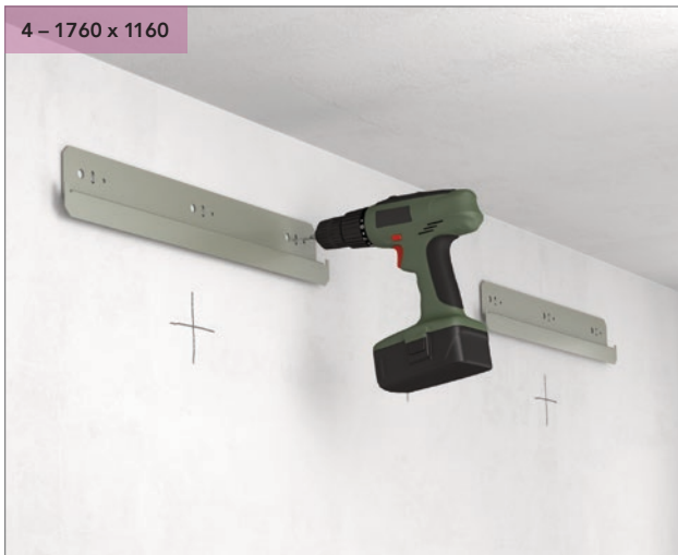
Просверлите отверстия и установите кронштейн для установки.
