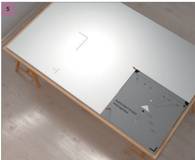
Установите разметочный шаблон в нижний правый угол с задней стороны стеновой панели Rockfon Eclipse. Отметьте карандашом центральные линии, используя левый верхний угол разметочного шаблона, и положение регулирующего упора, обеспечивающего нужное расстояние.
