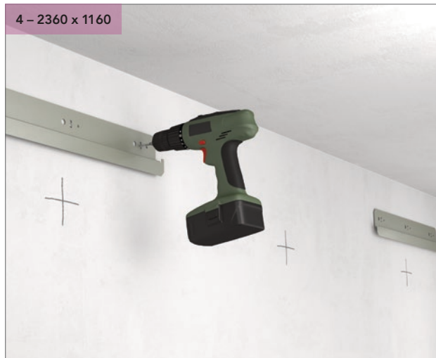
Просверлите отверстия и установите кронштейн для установки.
