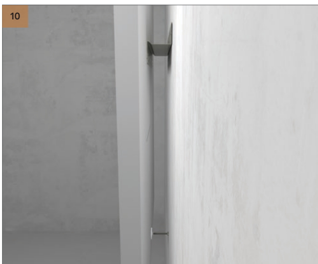
Установите стеновую панель Rockfon Eclipse на кронштейн для установки к стене и отрегулируйте положение регулирующего упора до выравнивания стеновой панели.
