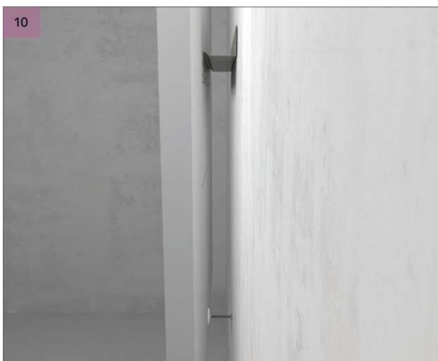
Установите стеновую панель Rockfon Eclipse на кронштейн для установки к стене и отрегулируйте положение регулирующего упора до выравнивания стеновой панели. См. 10 - Подробная информация.
