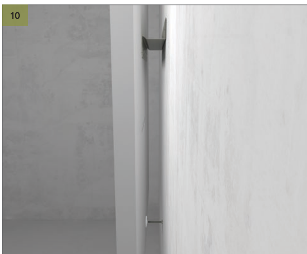
Установите стеновую панель Rockfon Eclipse на кронштейн для установки к стене и отрегулируйте положение пластикового регулирующего упора для выравнивания стеновой панели.
